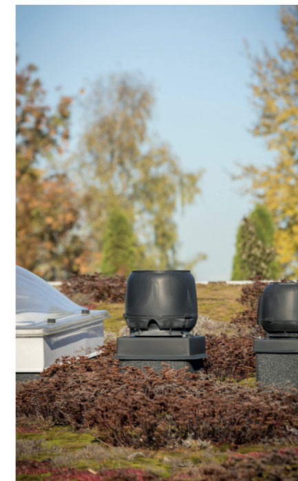
Wentylatory na dachu płaskim
